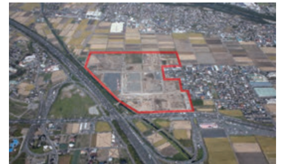
高崎玉村スマート IC 北地区工業団地
